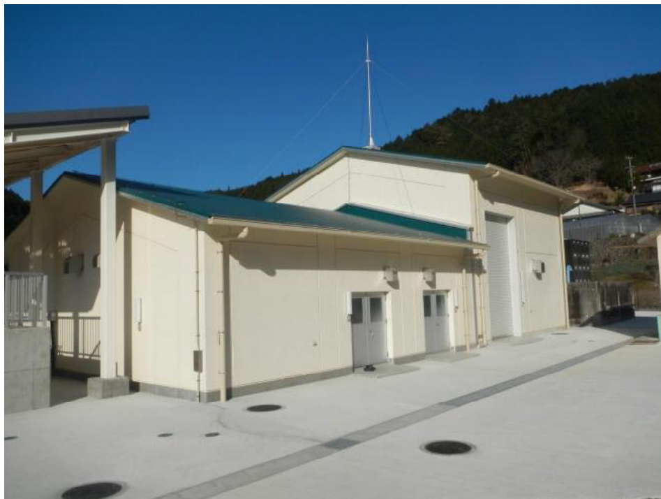
赤川簡易水道 切井浄水場
