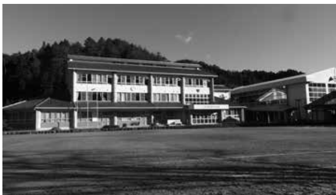
▲佐見小学校として使用する予定の佐見中学校校舎
