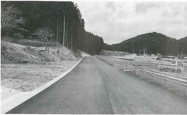
国道256号で改良された区間(小野地内)
