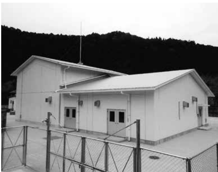
白川簡易水道 中川浄水場完成写真
