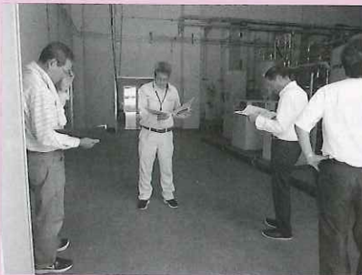
監査委員による現地実査(中川浄水場)
