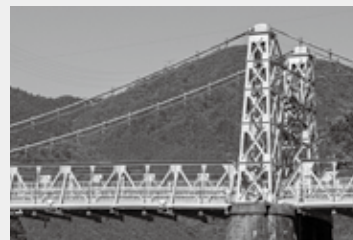
▲白川橋のトラス構造
