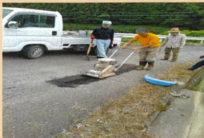
（舗装の簡易補修）
