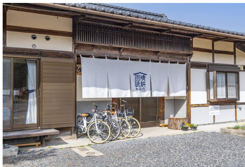
古民家を改修したゲストハウス「晴耕雨読とみだ」も私たちの職場です。
