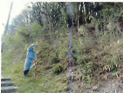
斜面の勾配・高さを確認
