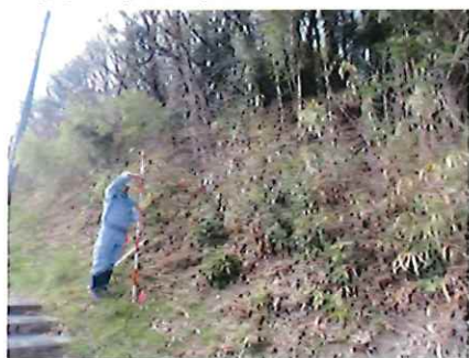
斜面の勾配・高さを確認
