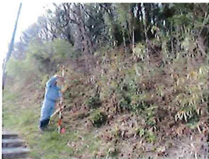
斜面の勾配・高さを確認
