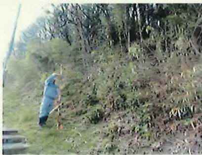
斜面の勾配・高さを確認
