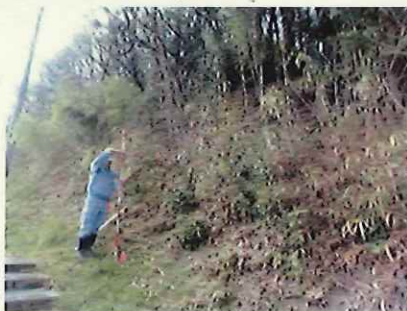
斜面の勾配・高さを確認
