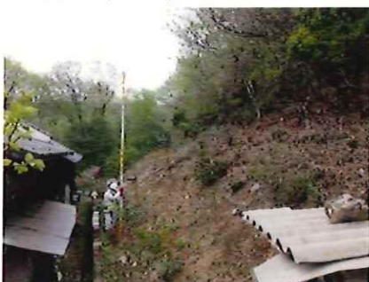
斜面の勾配・高さを確認
