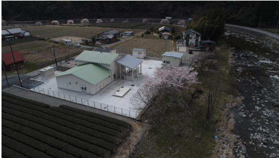
白川簡易水道 中川浄水場
